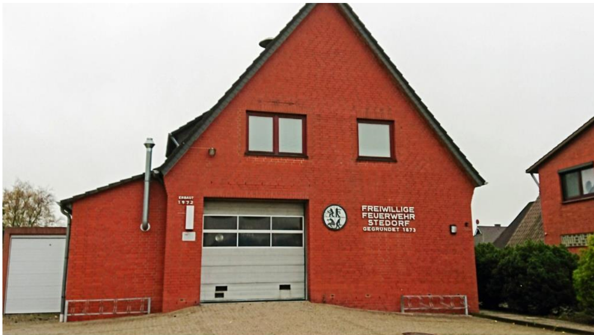
Feuerwehrhaus Baujahr 1972 - Anbau 1986 - Garage 2002
